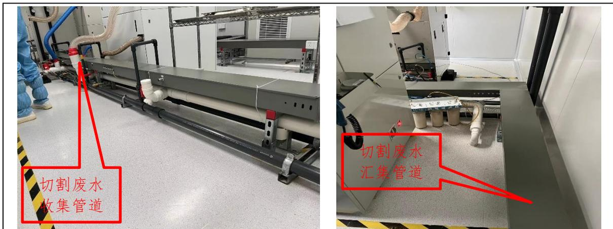
图 3-3.切割废水收集排出系统
