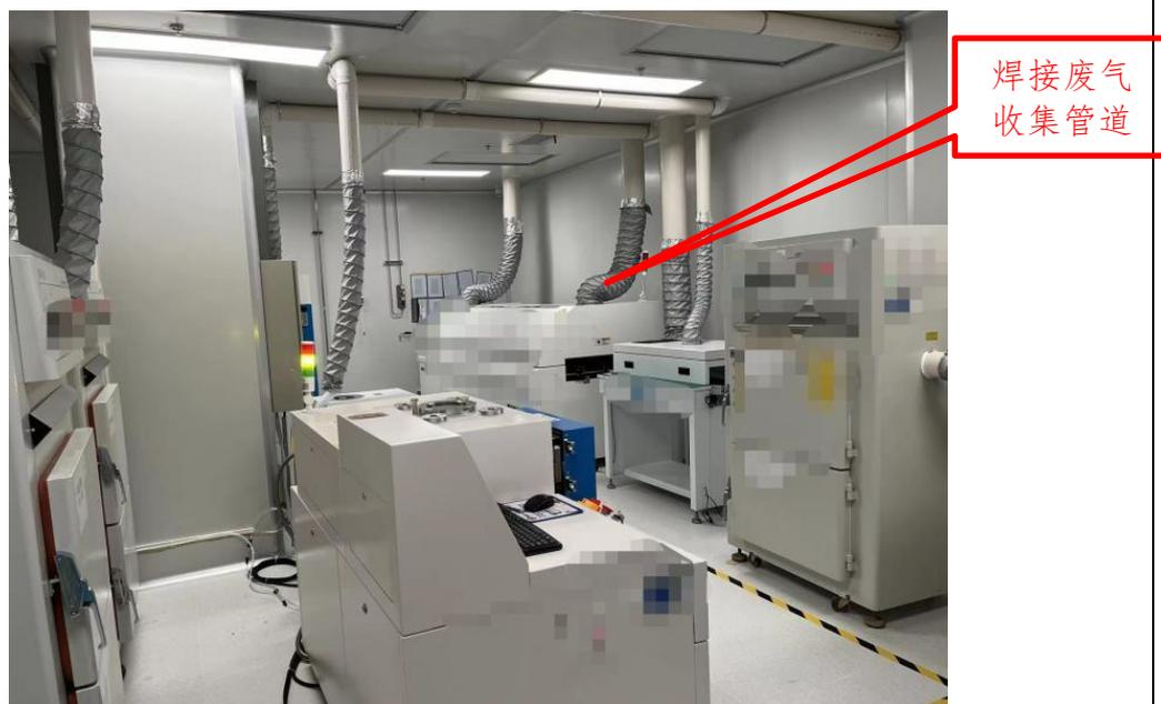
图 3-1.焊接废气收集系统
