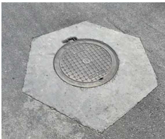
改造后污水井
